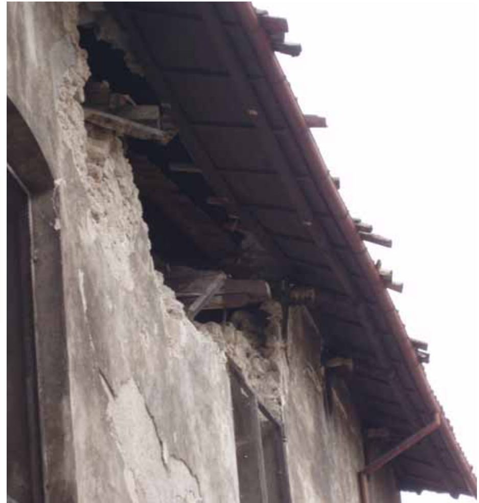
Edifício em alvenaria de pedra em L'Áquila
