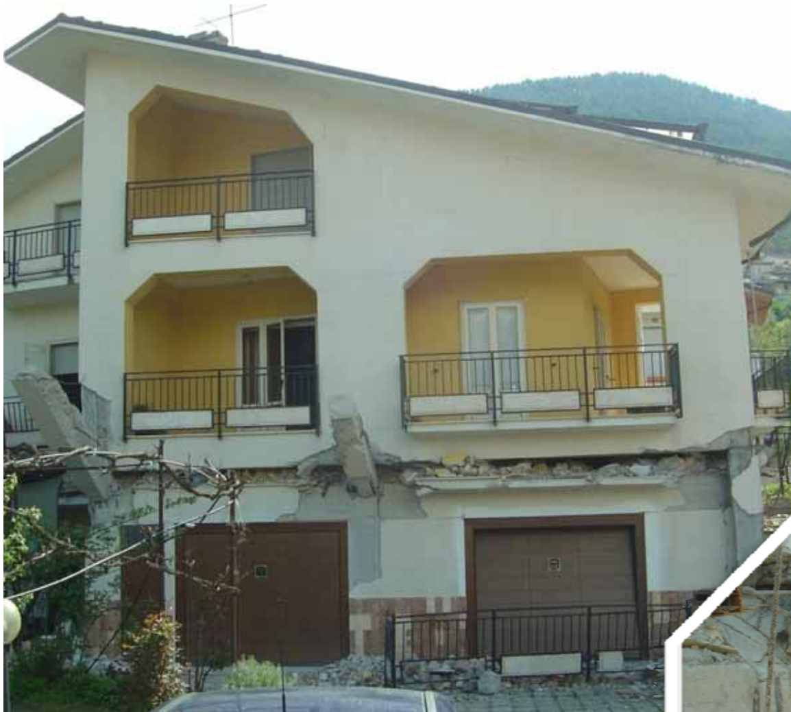
Edifício em Pianola
