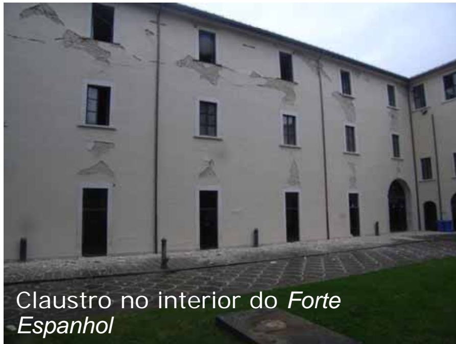
Corpo sem tirantes de reforço
