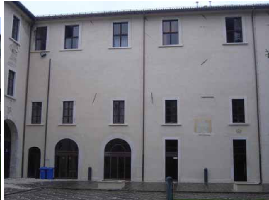
Corpo com tirantes de reforço
