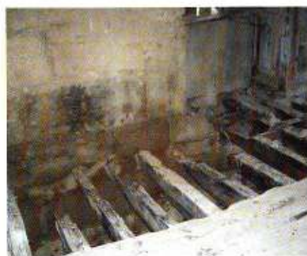
Pormenor de um pavimento do rés-do-chão, de madeira. Os estragos são sobretudo devidos à entrada da água da chuva
