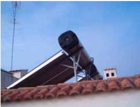
Inspeção do sistema solar térmico para aquecimento de águas sanitárias, existente, com cerca de 20 anos, de forma a verificar a sua eficiência.
