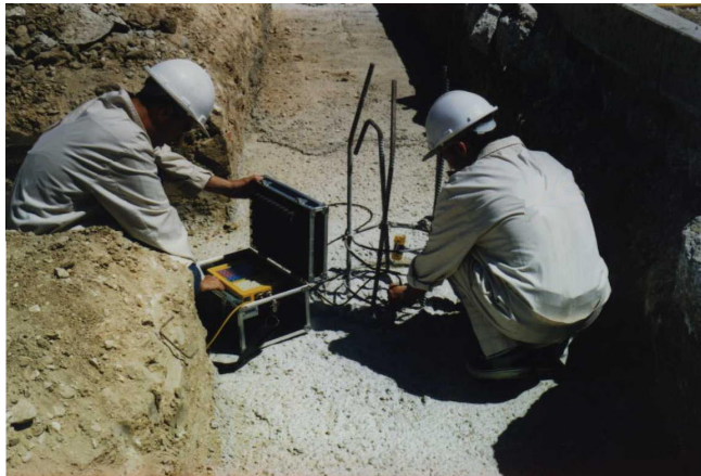
Fig. 2 – Execução do ensaio em obra.
