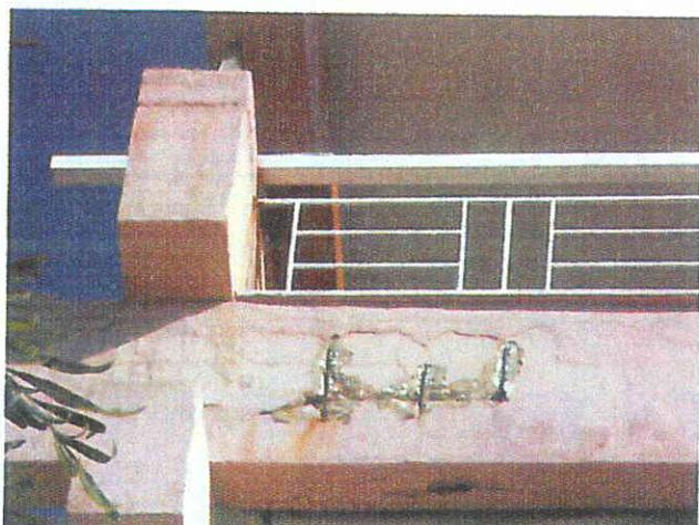
> Figura 11 – Corrosão de armaduras e delaminação do betão de recobrimento.
