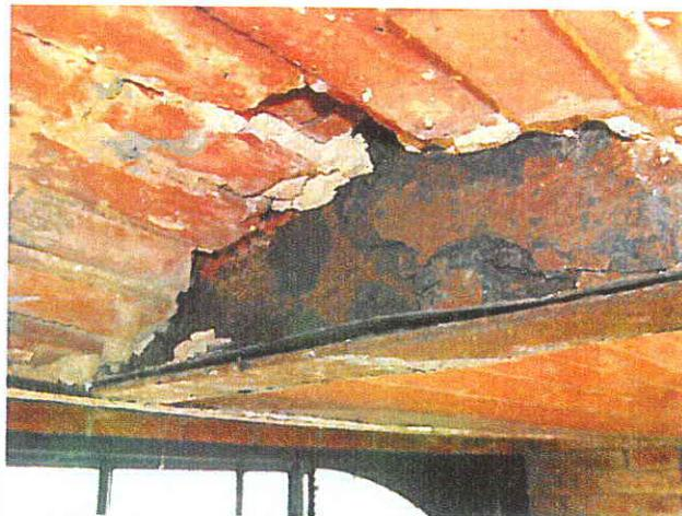
> Figura 10 – Redução da secção resistente do perfil metálico de um pavimento devido à corrosão.
