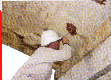
Fig. 3 - Observação endoscópica de uma ponte para caracterização estrutural.
