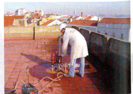
Fig. 4 - Extração de carote na laje de cobertura de um edifício, para caracterização do material.
