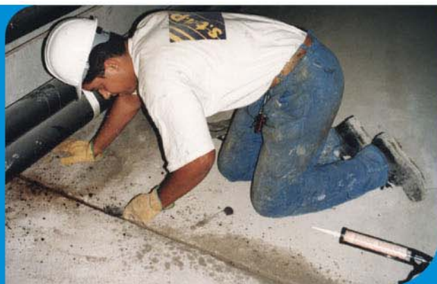
↓ REPARAÇÃO E PREENCHIMENTO DE JUNTAS COM MASTIQUE
