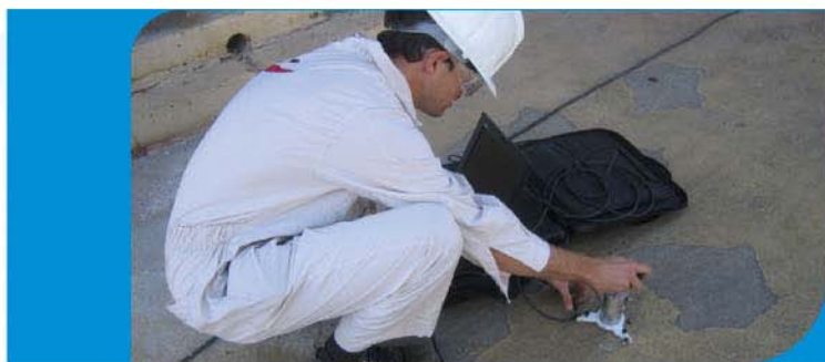
↓ AVALIAÇÃO DA ESPESSURA E DAS CONDIÇÕES DE FUNDAÇÃO DE UMA LAJE ATRAVÉS DE ENSAIOS ULTRA-SÓNICOS DE IMPACTO-ECO
