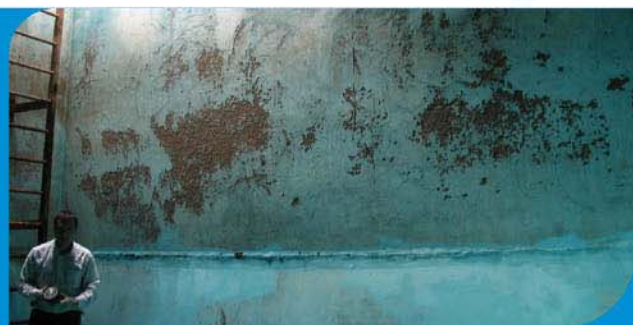
↓ INSPECÇÃO SANITÁRIA DE UM RESERVATÓRIO
