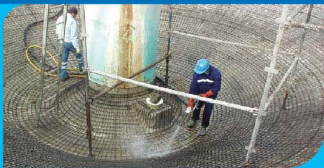
REFORÇO DE UMA LAJE DE FUNDO DE UM RESERVATÓRIO
