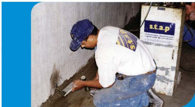
↓ INJEÇÕES DE CALDAS DE POLIURETANO HIDROACTIVAS PARA SELAGEM DE FENDAS
