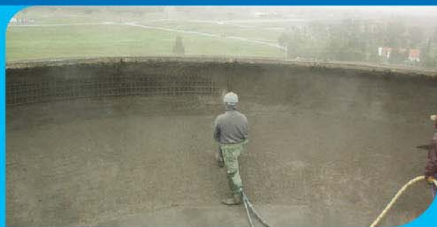
APLICAÇÃO DE BETÃO PROJECTADO
