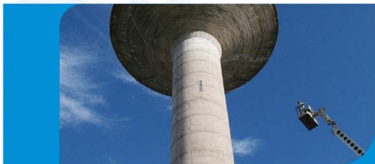
↓ INSPECÇÃO DE UM RESERVATÓRIO ELEVADO
