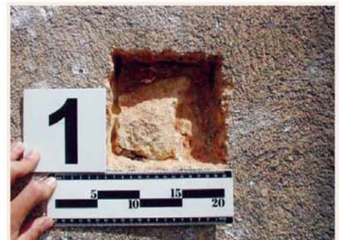
Extracção de uma amostra de um reboco antigo para caracterização laboratorial.
