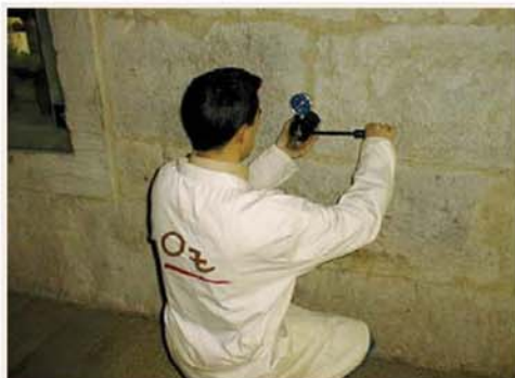
Avaliação das propriedades mecânicas de uma argamassa de assentamento através do ensaio de arrancamento de uma hélice.
