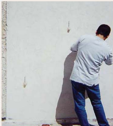
Instalação de tubos de Karsten num reboco para avaliação in situ da sua porosidade.
