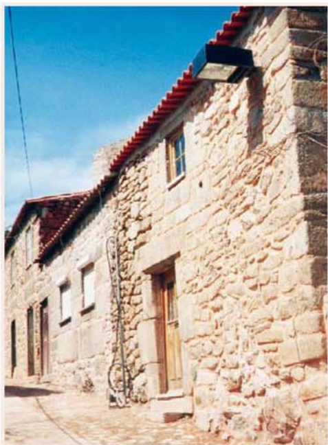
Refechamento de juntas na aldeia histórica de Castelo Rodrigo.
