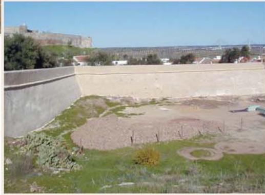
Forte de S. Sebastião, Castro Marim: antes e depois da intervenção.
