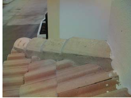
Foto 7) Pormenor construtivo mal concebido.
