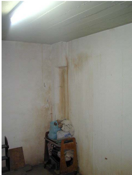
Foto 8) Infiltração de humidade. Deficiente isolamento dos elementos construtivos, nas caves, em relação ao terreno.
