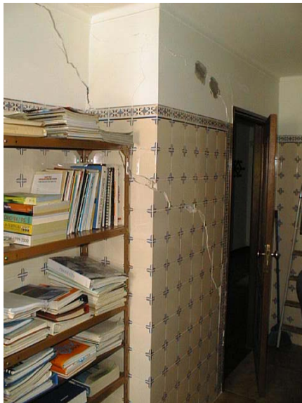
Foto 1) - Corrosão das armaduras. Espessura de recobrimento insuficiente.
