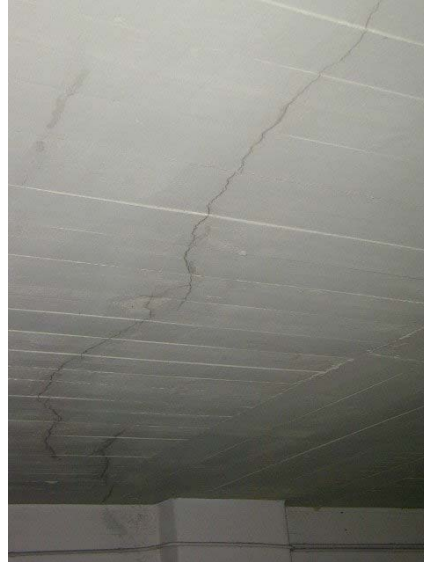
Foto 2) Fendilhação. Má concepção face às principais acções.
