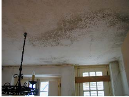
Foto 6) Infiltração de humidade. Deficiente pormenorização das ligações e remates da tela de impermeabilização subjacente.
