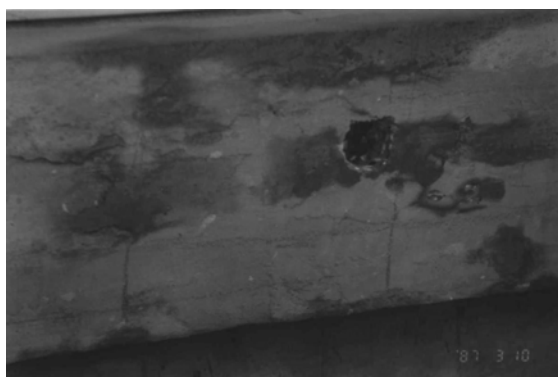
Figura 3 - Malha de armaduras detectada e ensaios para determinação da profundidade de carbonatação.
