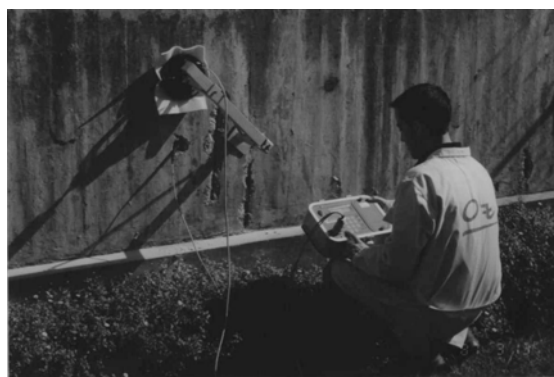
Figura 4 - Malha de armaduras detectada e medição da intensidade de corrosão.
