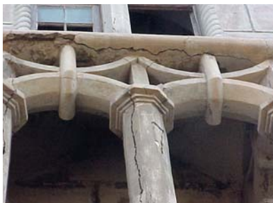
4 - Sintomas muito severos de corrosão das armaduras
