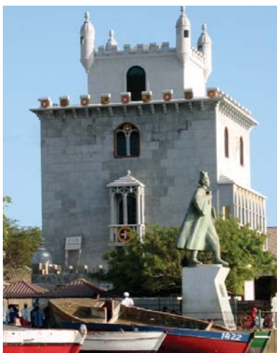
1 - Vista geral após a intervenção de recuperação
