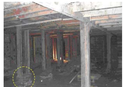
Figura 3 - Estrutura sob o palco constituída por pilares e vigas de madeira. Pormenor das fundações de basalto
