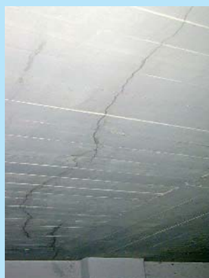
Foto 4: Fendilhação. Má concepção face às principais acções.
