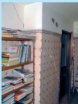
Foto 5: Fendilhação. Assentamento das fundações.
