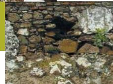
O Castelinho (Figura 5) apresenta várias fendas, principalmente na parte superior das muralhas, e o reboco em estado de desagregação, mesmo na zona reparada da fachada
