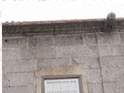
Fig.2 - Aspectos da fachada Oeste e da fachada Norte com e sem algerozes e gárgulas.
