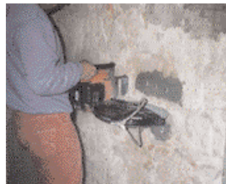
Corte da alvenaria para realização do ensaio de "macaco de plano"
