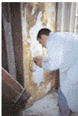
Medição da humidade nas paredes
